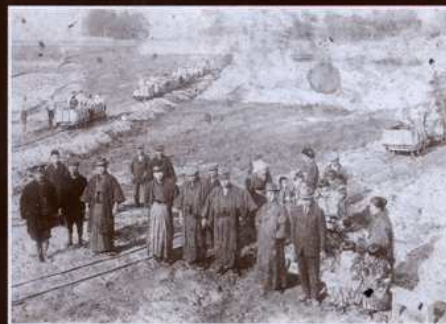
▲沼地の埋め立て (明和町・昭和4年) 文政6年(1823)と翌7年に利根川の堤防が決壊し、須賀地区に大きな沼と池ができた。この沼は長い間放置されていたが、この頃、埋め立てが始まった。工所用のトロッコには、大勢の作業員が乗っている。
