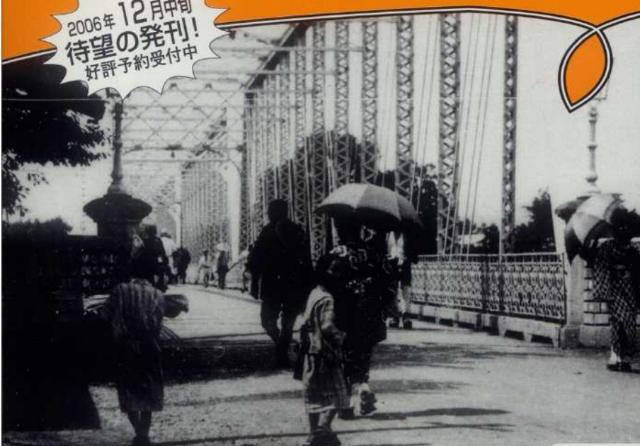
▲利根橋 (前橋市・大正後期~昭和初期) 石倉方面から見たところ。この橋は、明治32年に旧国道17号に架けられた群馬県初の鉄橋。昭和22年から24年にかけて立て続けに水害に遭って橋脚が傾いたため、同30年代に撤去された。
